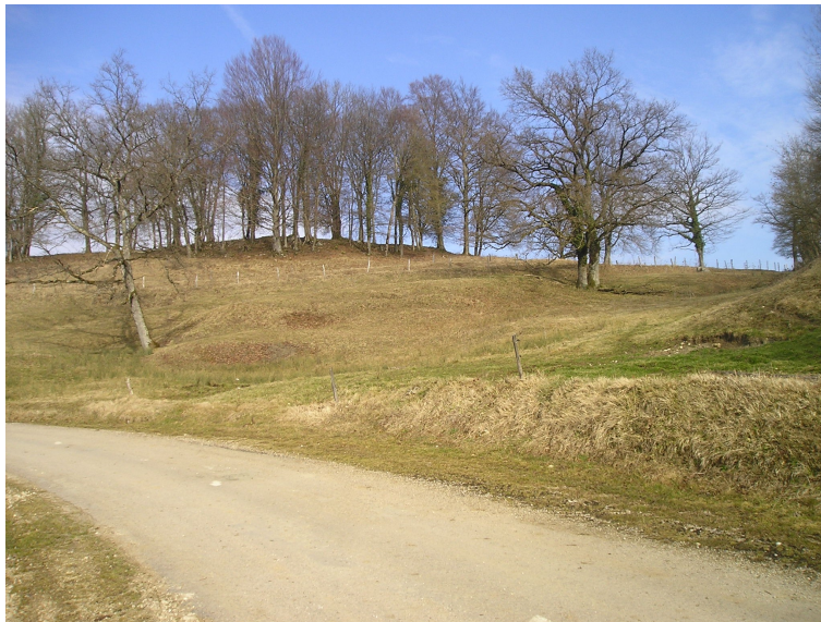
photo n° 6 : loupes de glissements dans les marnes à Mouillevillers.
